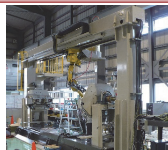
天吊り溶接ロボット
